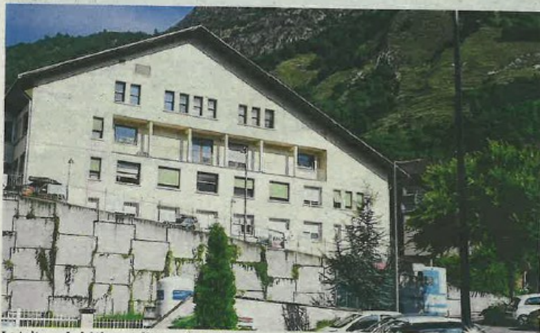
La toiture du bâtiment dit "Le Chalet" doit être refaite entièrement, soit 600 m 2 . Photo-Le DL/FT.
